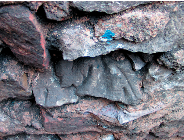
Abb. 6 Trier, Dominikanerkirche. Römische Spolie im Apsisfundament.
