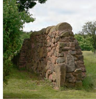
Der im Forst Arenberg abgeräumte Versturz ließ sich zu einer „wilden Mauer“ fügen, die der geplanten Rekonstruktion als Vorbild diente (B. Bienert in: Auf den Spuren der Langmauer 2004, 74 Abb. 6). Sowohl die Art der verhältnismäßig schwachen Fundamentierung als auch die Beschaffenheit der verwendeten Materialien können als Beleg für eine rasche Bauausführung gewertet werden.
