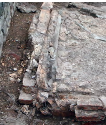
9 Trier, Barbarathermen, Caldarium. Wanne b mit Resten der Wand- verkleidung aus Marmorplatten.
