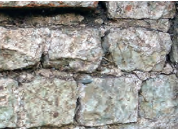
Trier, Barbarathermen, Frigidarium. Rest einer Bronzeklammer im Mauerwerk von Piscina N.
