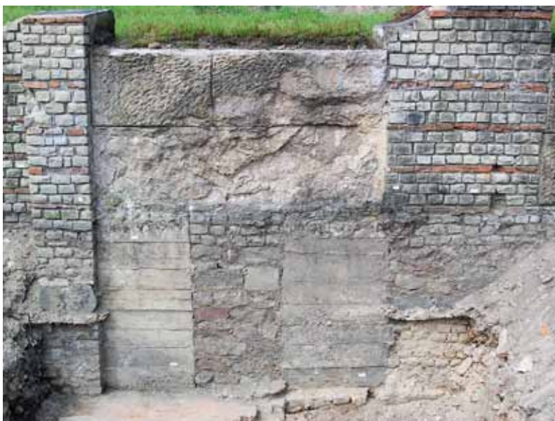
8 Trier, Barbarathermen. Caldarium-Wanne b'. Südlicher Teil der Westwand mit unge- schicht rekonstruierten Quadern von Osten.
