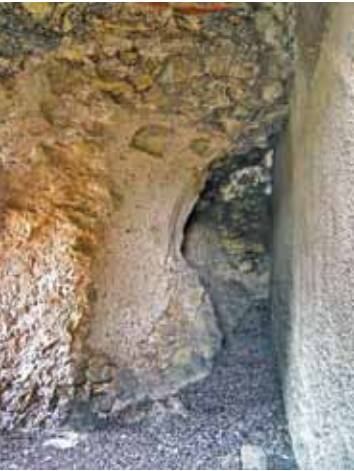
12 Trier, Kaiserthermen. Mittelalterlicher Hohlraum in der Südwand des Caldariums C, Ostende von Westen.
