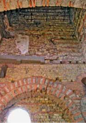
11 Trier, Kaiserthermen. Kesselraum 6, Nordwand von Süden mit mittelalterlichem Einbau.
