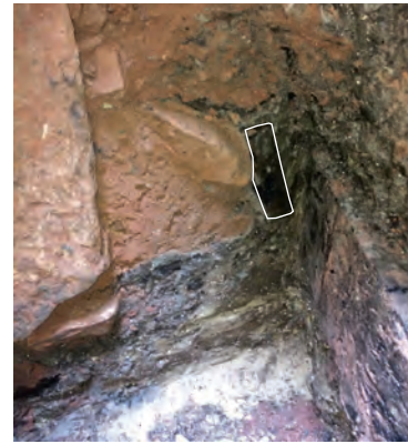
4 Trier, Nordallee. Abschnitt der Spundwandbohle (Probe 2).
