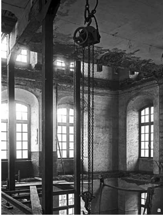
17 Trier, Kurfürstlicher Palast. Umbau zum Großmuseum, 1938. a Auskernung des Südostpavillions. b Einbau der tragenden Stahlgerüste.
