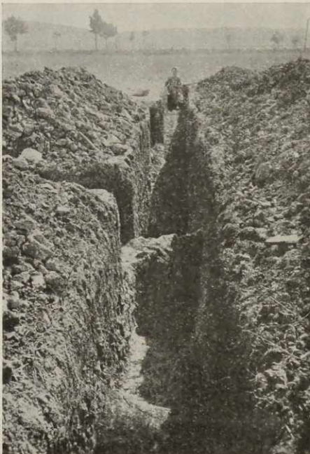
Abb. 2. Schnitt 12: Vorne die umbiegende innere Böschung des Grabens J. In der Mitte die künstliche Böschung des Grabens E.
