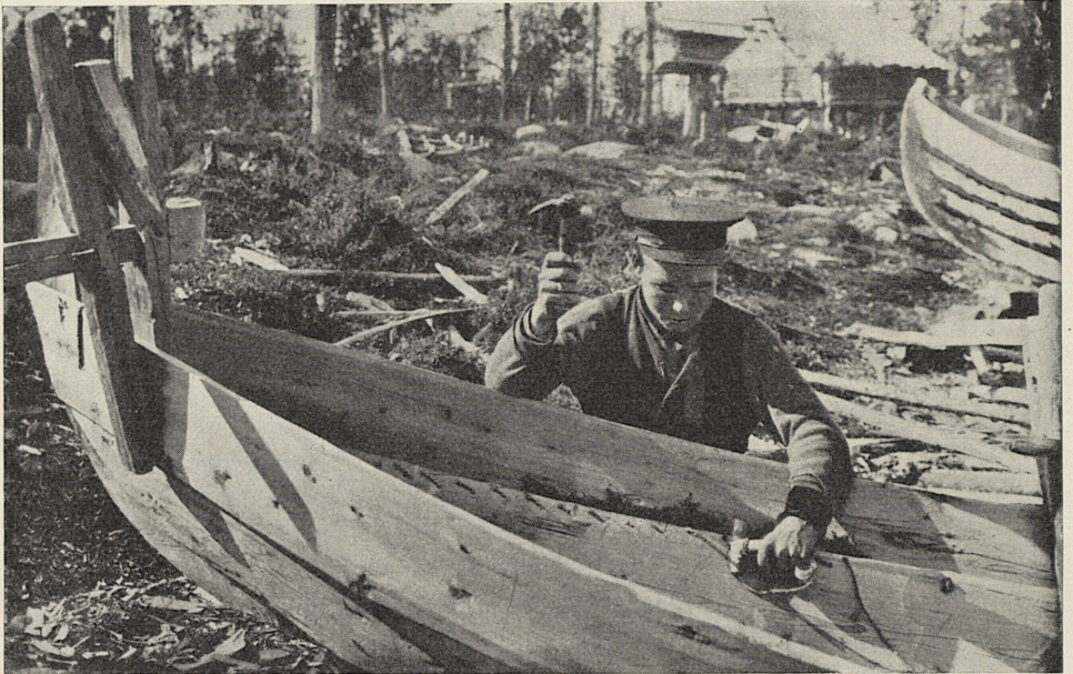
Abb. 13. Karelischer Bootbauer beim Zusammennähen der Planken. Aus: G. Hallström, Båtar och båtbyggned i rysska Lappmarken, Fataburen (1909).
