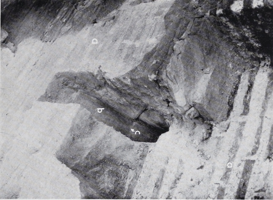
Trier, Aula Palatina. Innenwand. 1 Ansatz eines Luftabzugskanals der Hypokaustheizung. 2 Durchblick durch einen Luftabzugskanal.
