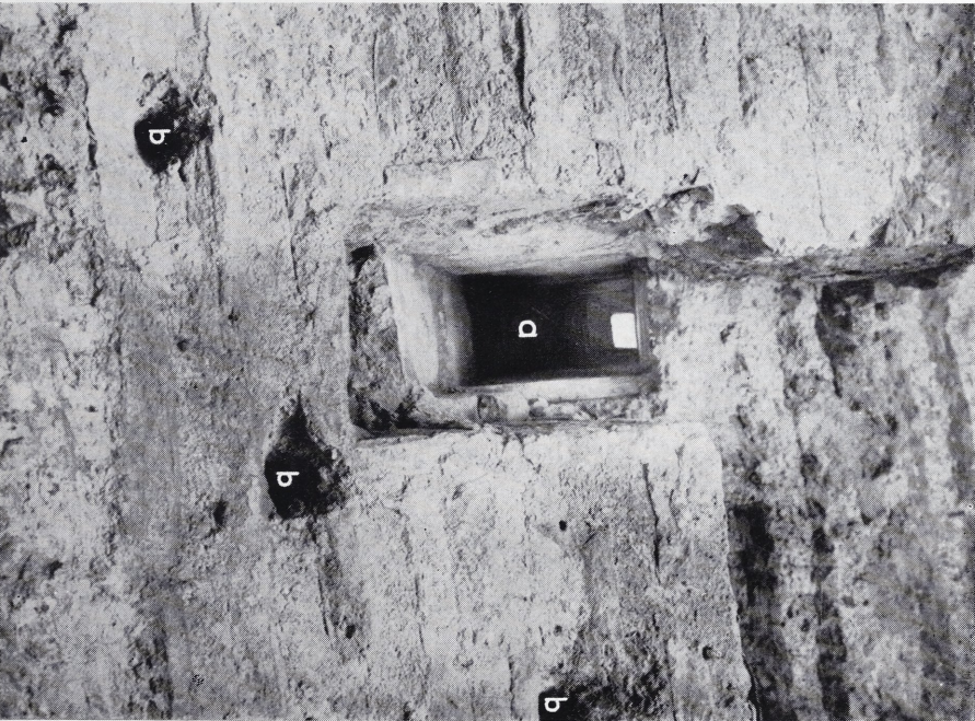
Trier, Aula Palatina. Innenwand. 1 Ansatz eines Luftabzugskanals der Hypokaustheizung. 2 Durchblick durch einen Luftabzugskanal.
