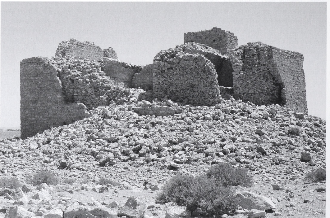
Abb. 11. Gasr Wames im oberen Wadi Sofeggin. Burgusartige Kleinfestung. West- und Südansicht mit Tonnengewölben und Mauerverstärkungen der rückwärtigen Eckräume.
