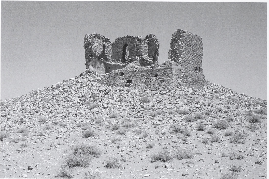
Abb. 6. Gasr Duib im oberen Wadi Sofeggin. Burgartige Kleinfestung ( centenarium novum [ Philippianum ]). Südwestseite, Südecke und Nordwestseite mit Instandsetzungen.
