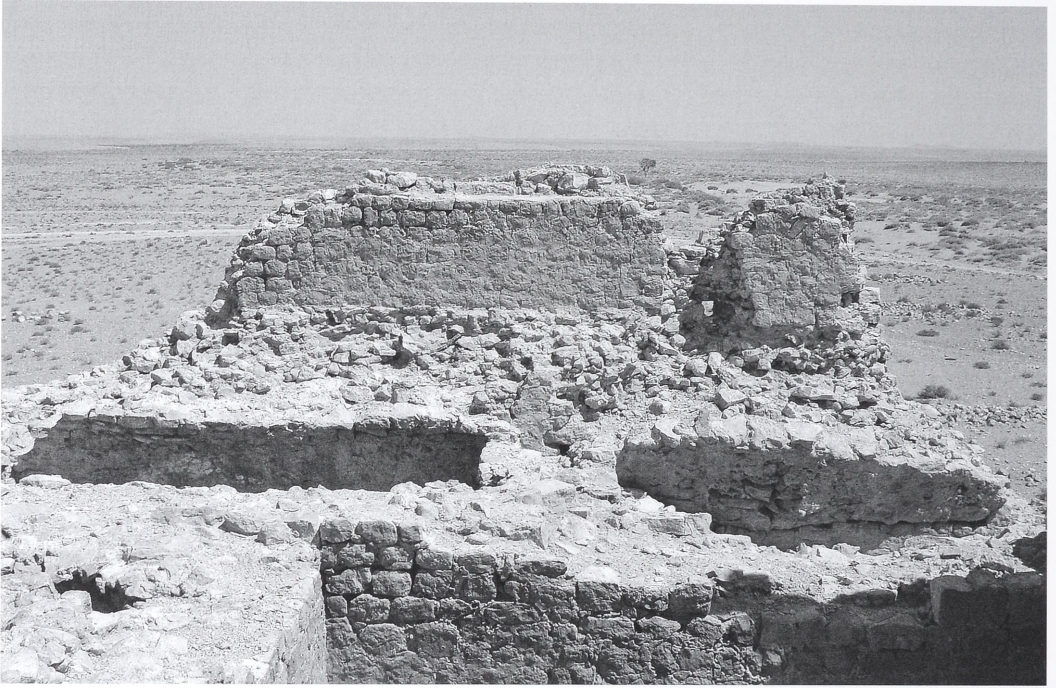
Abb. 13. Gasr Wames im oberen Wadi Sofeggin. Burgartige Kleinfestung., Nördlicher Bereich mit Brüstungsmauer von innen mit zugesetzten Scharten über Caementicium-Flachdach mit eingestürzten Tonnengewölben von Süden.
