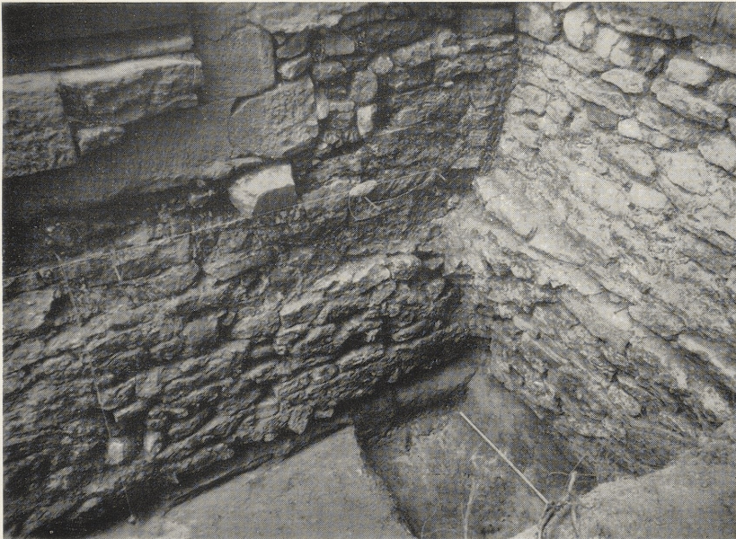
Ingelheim, Saalkirche. 1 Nördliche Langhauswand, Innenseite mit Resten des Aufgehenden in Schnitt 12. 2 Ecke zwischen Langhaus und nördlichem Querhausarm mit älteren Mauerteilen im Querhausfundament direkt vor der Langhausmauer.
