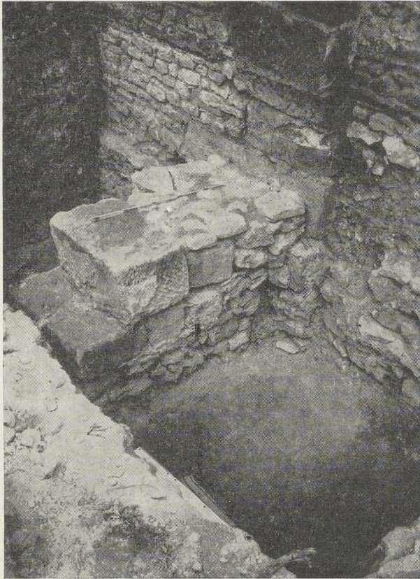
Abb. 4. Ingelheim, Saalkirche. Alte Südwestecke des Langhauses mit nachträglich vorgesetzter Fundamentverstärkung.
