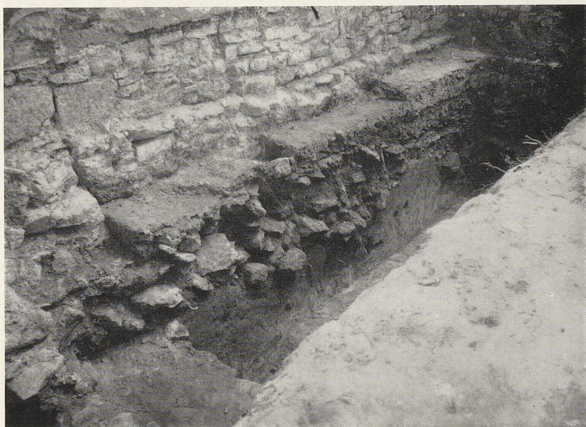
Ingelheim, Saalkirche. 1 Westwand des nördlichen Querhausarmes mit senkrechter Bau- fuge. 2 Reste alter Fußböden im Kirchenschiff vor der westlichen Abschlußwand von 1707. Vorne links nördliche Langhauswand.
