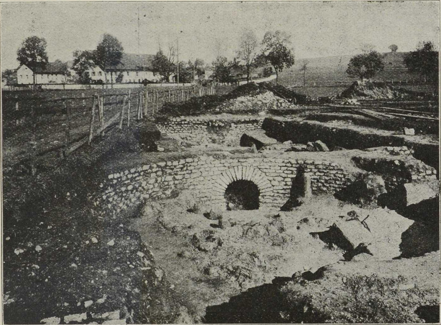
Abb. 3. Sudatorium, von Südwesten gesehen
