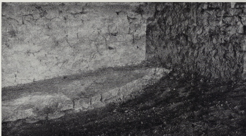
Abb. 3. Fundament der nördlichen Koncha des Saales B in Abb. 1.
