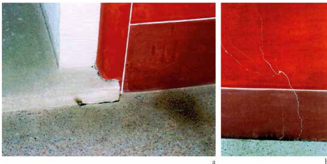
Abb. 5. Archäologischer Park Carnuntum (Niederösterreich), Villa Urbana. Kleine Risse im Randbereich des Estrichs, dadurch Eintritt von Ruß und Rauchgasen (schwarze und dunkelbraune Verfärbungen) aus dem Hypokaust in den Raum. Bei den wesentlich größeren und zahlreicheren Spalten zwischen den Bodenbrettern einer hölzernen Hypokaustheizung würden wesentlich mehr giftiges Rauchgas und Ruß in den Raum gelangen.
