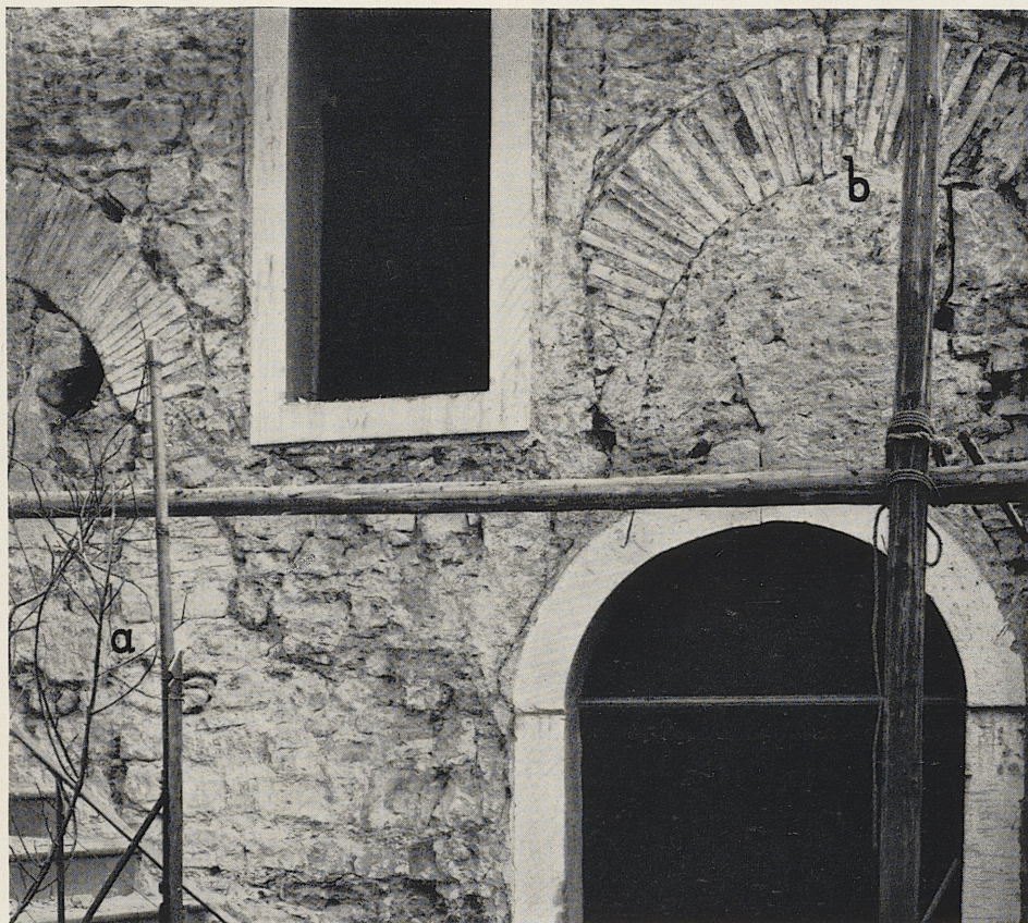
Abb. 2. Pfalz, Haus Stiftstr. 3. Reste der Erdgeschoßfenster des 'Bades': a. Gewände aus Bruchsteinen mit Ziegeldurchschuß, b. Bogen aus Ziegeln mit Deckziegeln.
