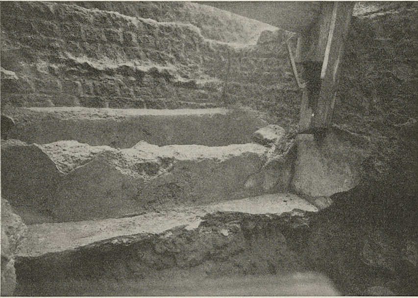
Abb. 3. Die Gräfte der kleinen Grabkammer an der Severinstraße von Nordosten. Das rauhe Mauerwerk der hinteren Wand ist ein Rest des Gewölbeanfanges.
