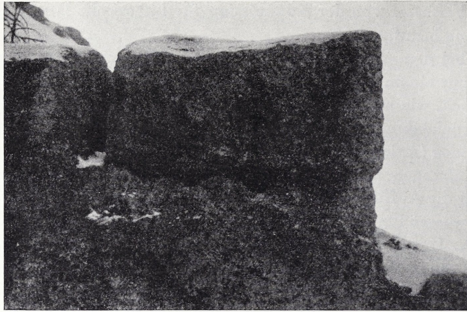
Abb. 1. Steinbruch von Cernavoda. Block mit Trennrinne und Keillöchern.
