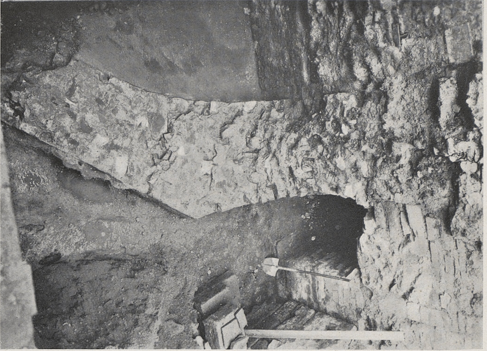
St. Peter auf der Zitadelle in Metz. 1 Nordöstlicher Apsisansatz, rechts davon ein Nebeneingang. 2 Trennfuge zwischen Apsis und merowingischer Zumauerung.
