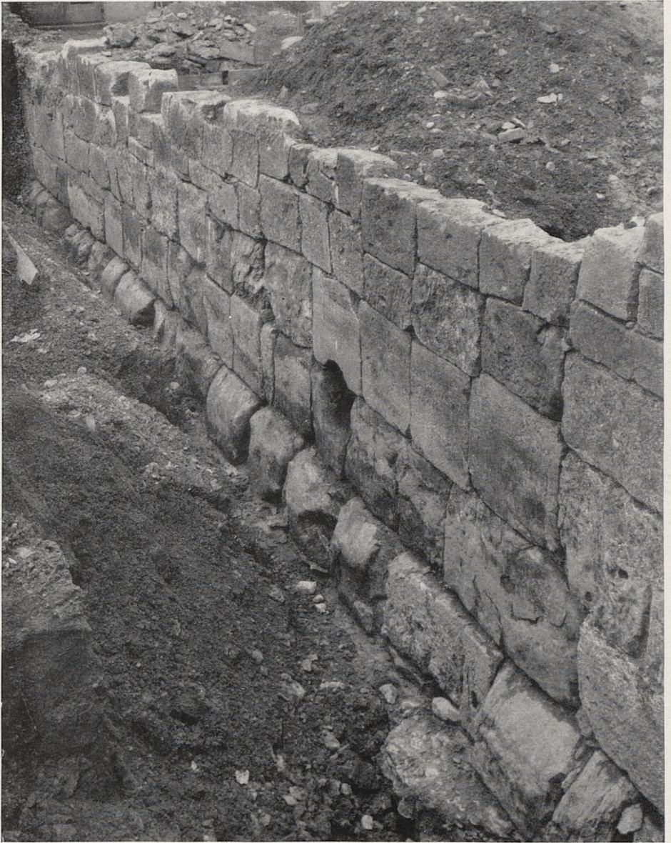
Regensburg. Gesamtansicht der römischen Lagermauer. Grabung 1955. Vgl. Beilage 7 .
