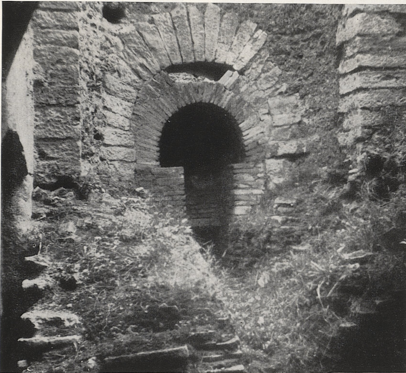
1. Karthago, Große Thermen. Blick von den Baderäumen zur See. Untergeschoß und Reste der Hypokaustenräume mit Pfeilern aus Lavagestein. 2 Djemila, Große Südthermen. Bedienungsgang mit Präfurnium und Resten des Unterbaues für Warmwasserkessel, Öffnung für Testudo, Ausmauerung des Feuerloches und des Kanals mit Ziegeln.
