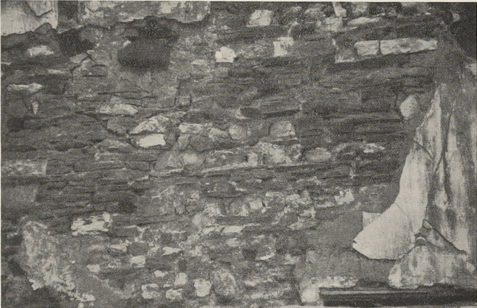
Abb. 6. Aachen. Buchkremerstraße 5. Nördliche Außenwand, Ausschnitt. Verband: Grauwacke, Mörtel mit Ziegelschlag; wahrscheinlich karolingisch. 1955 abgebrochen.
