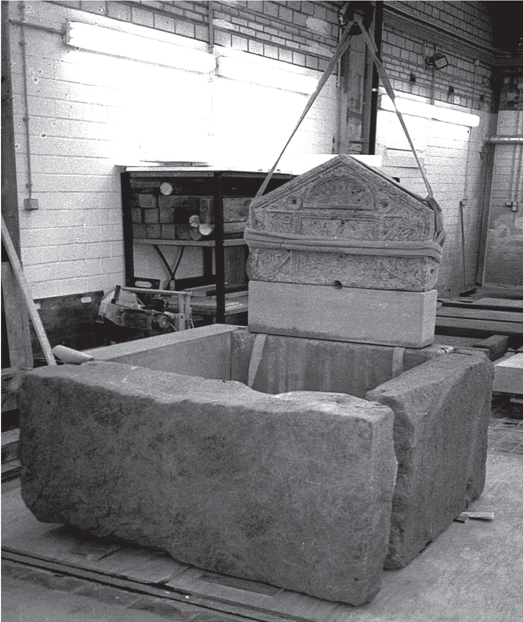
Abb.6. Obernburg. Laufbrunnen aus dem Peristyl der Benefiziariestation. Arbeitsaufnahme vom provisorischen Aufbau während der Restaurierung. Ergänzt sind die rückwärtige und linke Seitenwange des Brunnentroges sowie der Zwischenstein unter dem Brunnenstein.
