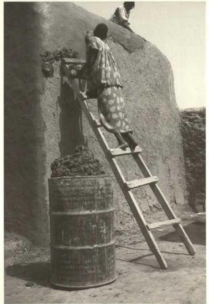
Village Kotoko (région de Goulfey), restauration de maison en terre
