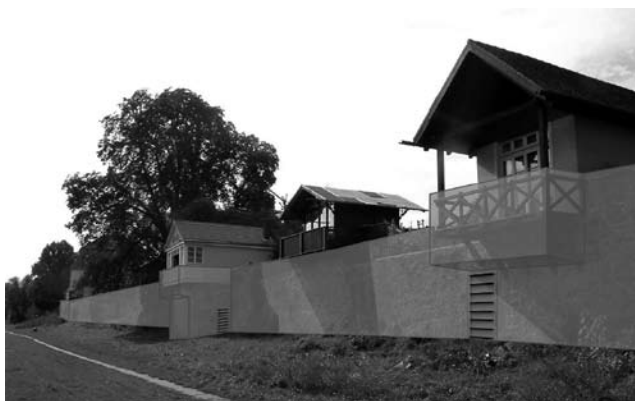
Abb. 10 (o.) und 11 (u. l.) Mittelalterliche Stadtmauer, Technische Vorplanung der Hochwasserschutzmauer, Fotomontage und Schnitt
