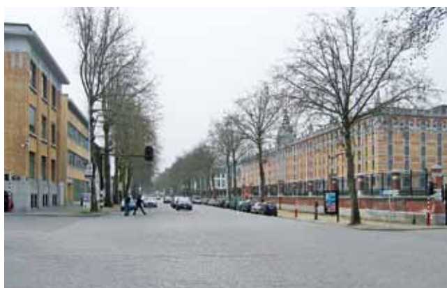
Pavés en porphyre. Pose traditionnelle jointive en quinconce, contreboutée par des bordures en pierre bleue (avenue du Port à Bruxelles, vaste artère industrielle du quartier maritime résistant depuis plus de 100 ans à un important charroi quotidien, mais non entretenue depuis plus de 30 ans)
