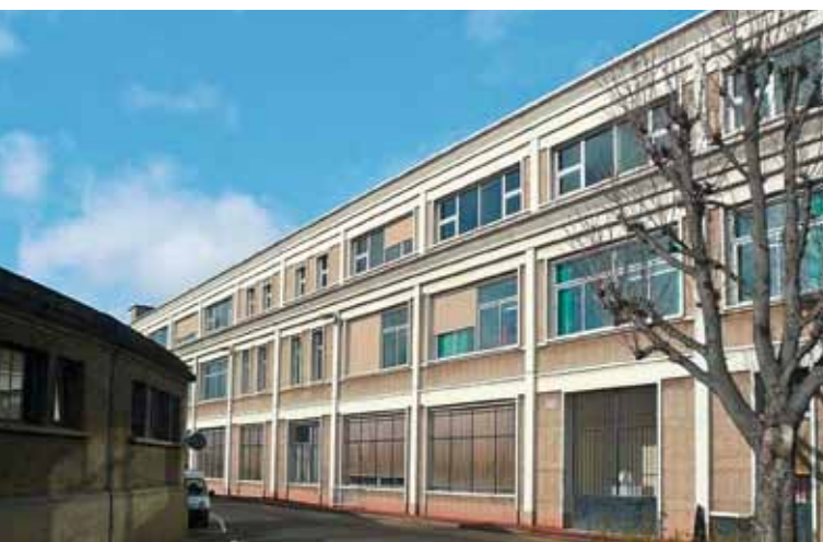
Bâtiment administratif, menacé de destruction (photo: Docomomo)
