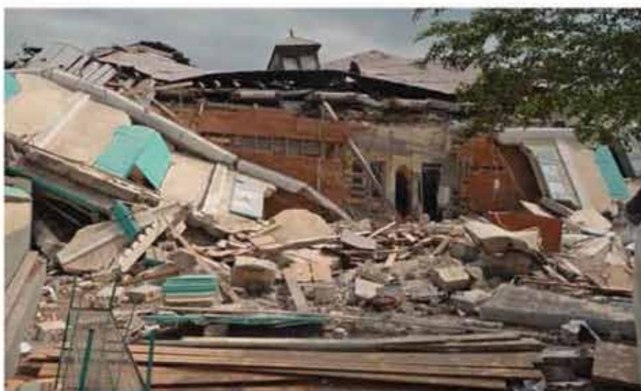
Le bâtiment originel de Saint-Louis-de-Gonzague, achevé en 1888 et aujourd'hui en ruines.
