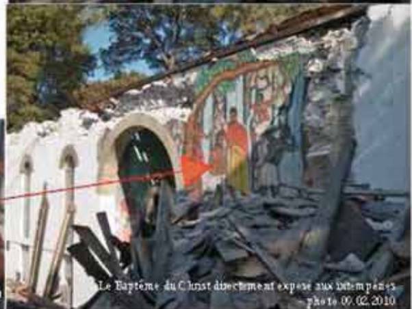
Vue des décombres all'intérieur de l'église, dont une partie peut amé- ment servir à la mise en oeuvre d'un parasol, provisoire pour une mise hors d'eau des peintures murales. Etat après tremblement de terre - photo 09.02.2010
