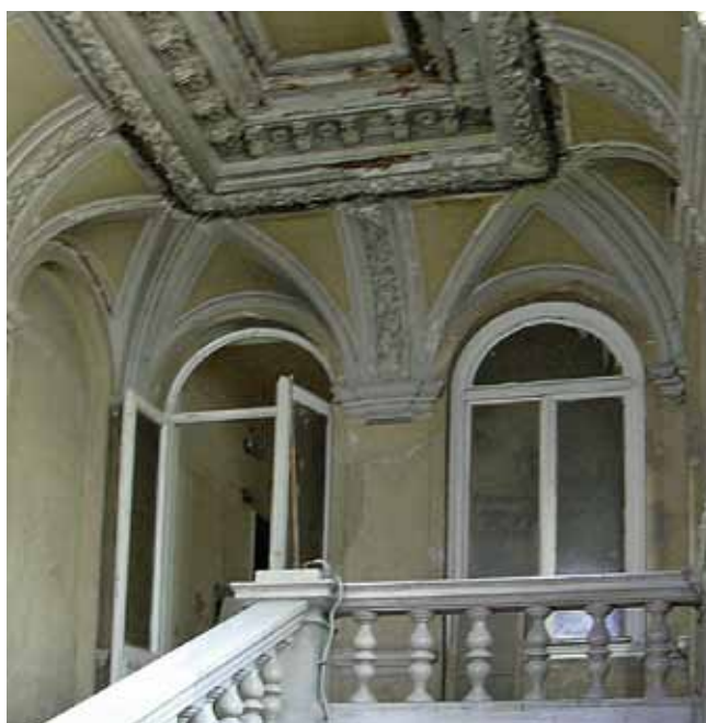
12 Reáltanoda Street, the stairway
