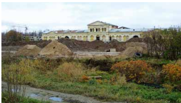
The stables of the grand ducal manor of Michailovka during restoration (a glass cupola will be erected in front) Конюшенный корпус великокняжеской усадьбы «Михайловка» в ходе реконструкции (перед зданием планируется построить стеклянный купол).
