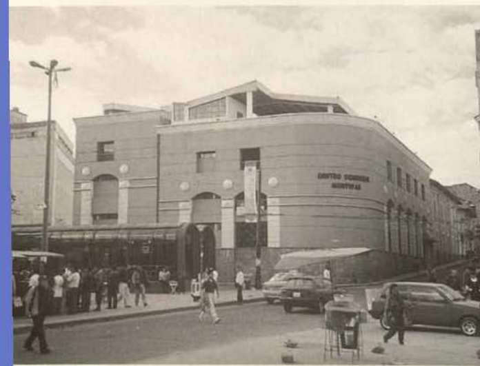
Uno de los 6 grandes estacionamientos vehiculares ubicados en el centro histórico, de los cuales solamente uno funciona para esa función, mientras que los otros se están readecuando para centros comerciales populares.
