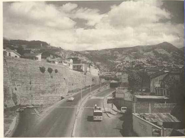
Viaducto de alta velocidad que atraviesa el centro histórico de Quito de oriente a occidente.
