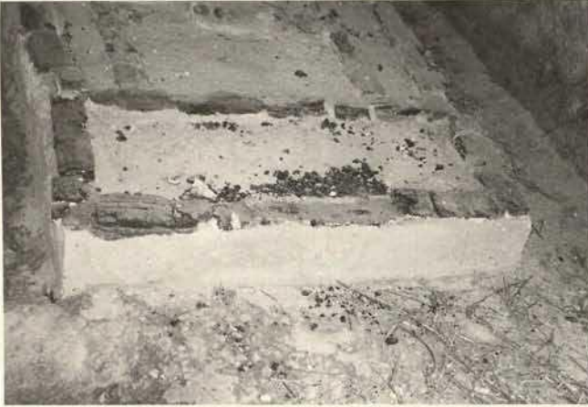
Casa del tramezzo di legno, crumbling wooden bed frame
