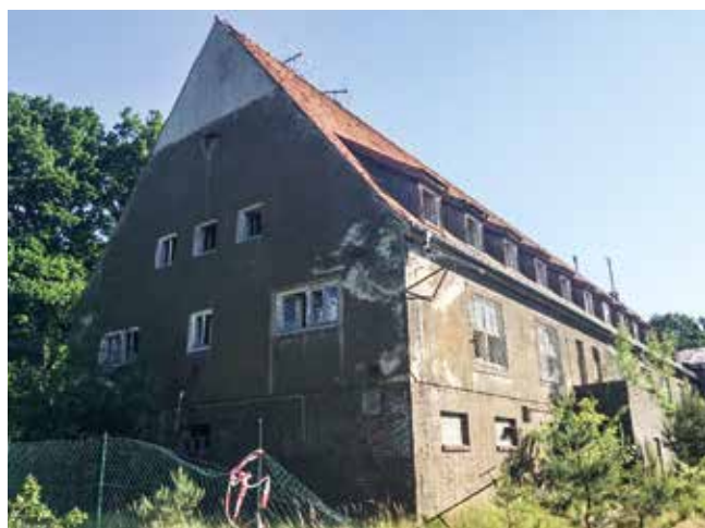
Fig. 4 Former 'Wirtschaftsgebäude' at Karlshagen before arson in 2016 (© P. Schneider/C. Röhl)
