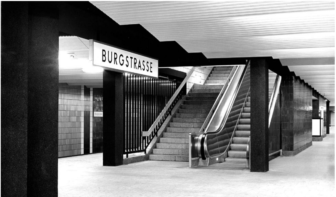
Abb. 2: Hamburg, Neubaulinie Billstedt, U-Bahnhof Burgstraße, Gestaltung Tunnel, Bahnsteig und Ausgang. Foto 1967
