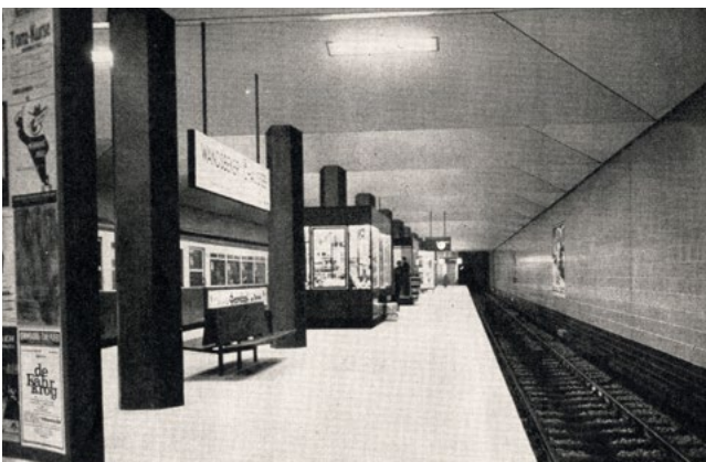
Abb. 3: Hamburg, Wandsbeker Linie, U-Bahnhof Wandsbeker Chaussee, Bahnsteigausstattung. Foto 1962
