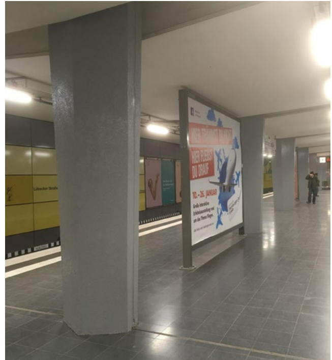
Abb. 11: Hamburg, Wandsbeker Linie, U-Bahnhof Lübecker Straße, sechseckiger Querschnitt der Tunnelstützen und Deckenform bauzeitlich 1961, Zustand 2018. Foto: Sabine Kock
