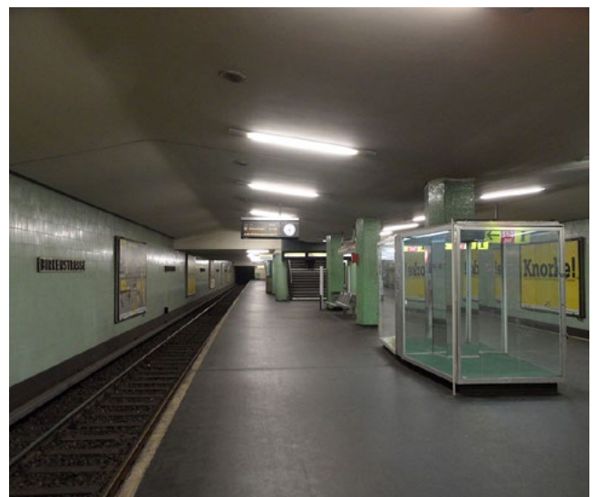
Abb. 2: Der Bahnhof Yorckstraße – späte 1960er – ist ebenfalls seit 2016 entkernt. Eine Sanierung hat bis Herbst 2019 nicht begonnen. Foto: Verena Pfeiffer-Kloss, 2014
