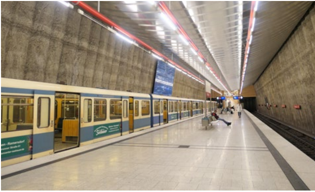
Abb. 11: U-Bahnhof Mangfallplatz, München, Foto 2019
