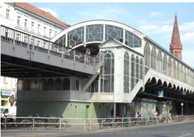
Abb. 1: U-Bahnhof Görlitzer Bahnhof (Hochbahnhof), 1898–1901 von Siemens & Halske. Foto 2007
