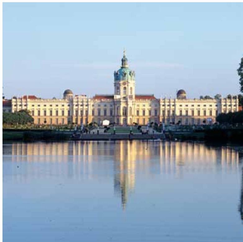
Abb. 2: Berlin, Schloss Charlottenburg, Ansicht der Gartenseite über das Bassin, 2007
