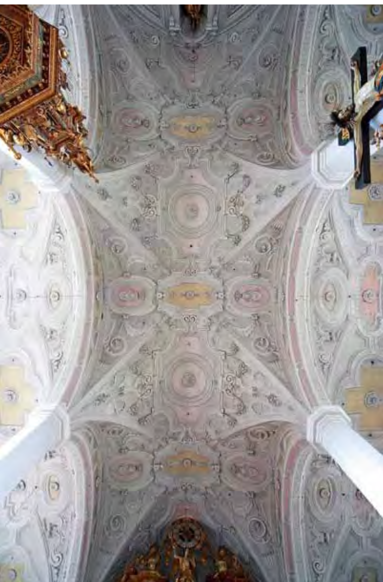
Abb. 6: Tuntenhausen, Innenansicht Foto: Neubauer Restaurierungswerkstätten
