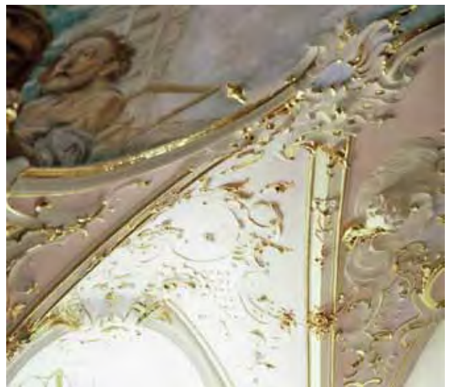
Abb. 12: Hohenpeißenberg, Wallfahrtskirche Mariä Himmelfahrt, Detail im Chor. Foto: Engel Kirchenmalerei Meisterbetrieb
