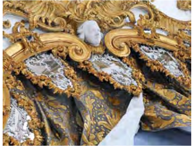
Abb. 9: Hängende Spiegelplatten über der Nordseite des Kaisersaals
