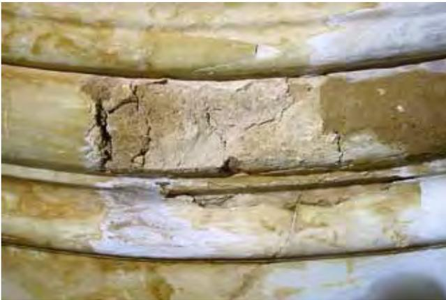
Abb. 14: Schloss Thalheim (Lkr. Nürnberger Land), Detail einer Stuckdecke mit Verfärbungen und Strukturschäden nach Brandschaden und damit verbundenem Löschwassereintrag, Zustand vor der Restaurierung 2005
