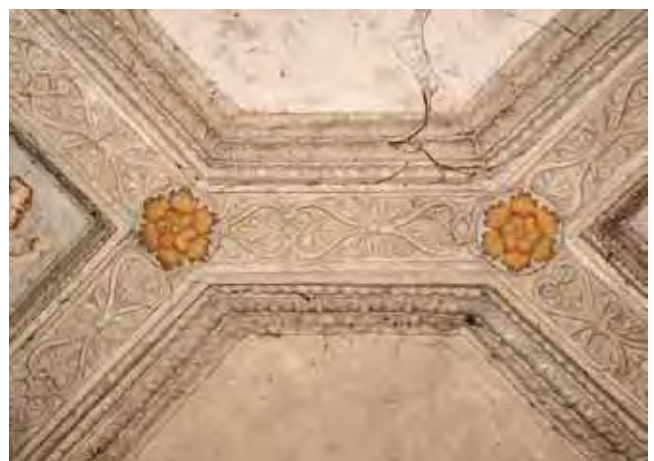
Abb. 4: Neuburg, Stuckspangen in Modeltechnik, aufgesetzte Eckrosetten
