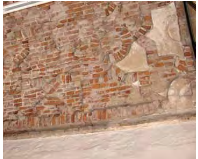
Abb. 2: Heidelberger Schloss, Mauertechnik
