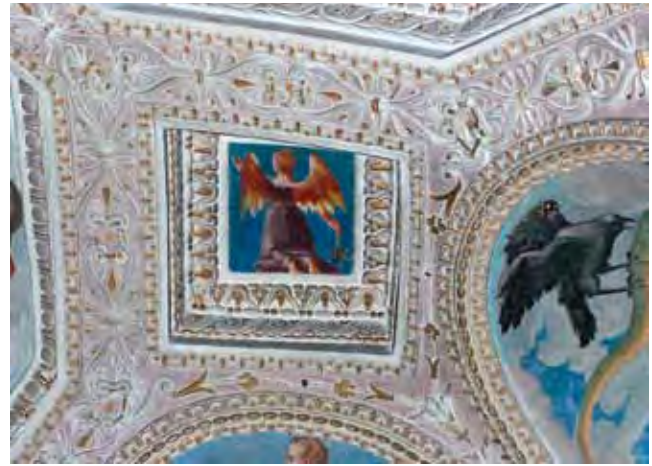
Abb. 5: Residenz Landshut, Sternenzimmer, Stuckspangen und Ecksituation
