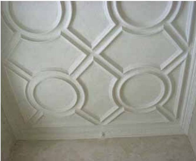
Abb. 26: Raum 105, Decke im Endzustand
