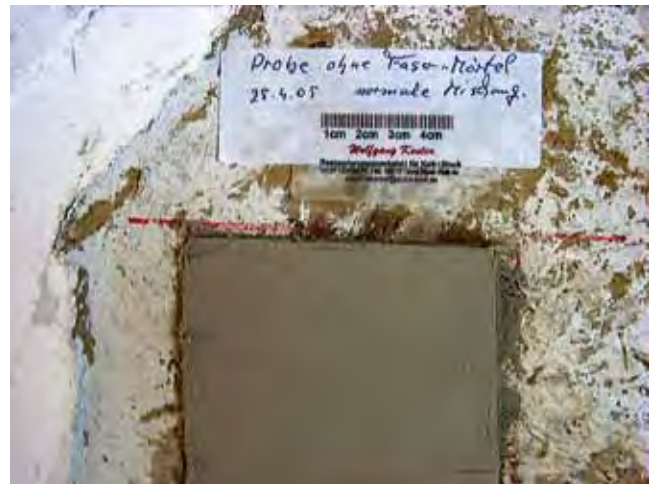
Abb. 18: Antragung von Kalkputz ohne Faserzugabe
