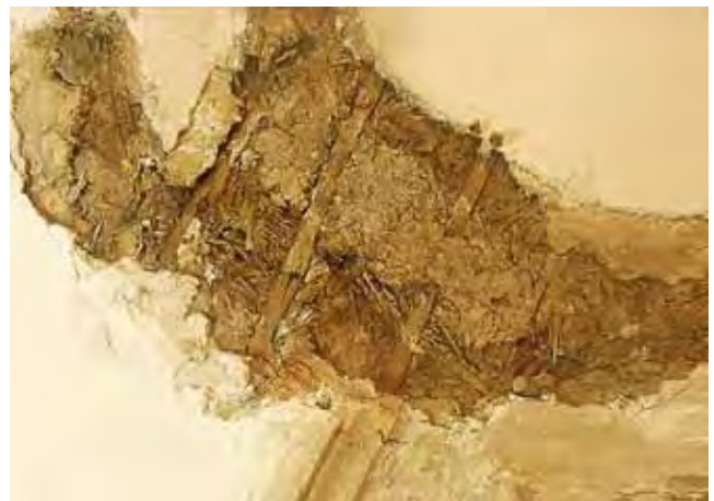
Abb. 4: Balken mit aufgenagelten Ruten
