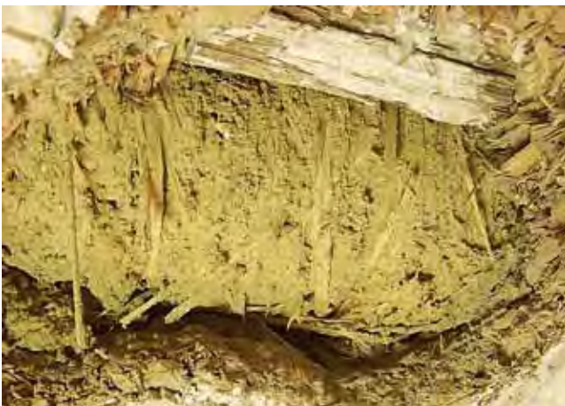
Abb. 3: Lehmwickel zwischen den Balken
