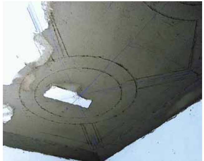
Abb. 22: Raum 105, Anlage der Stuckatur
