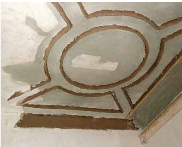
Abb. 23: Raum 105, Lehmkern und Rücklagenputz
