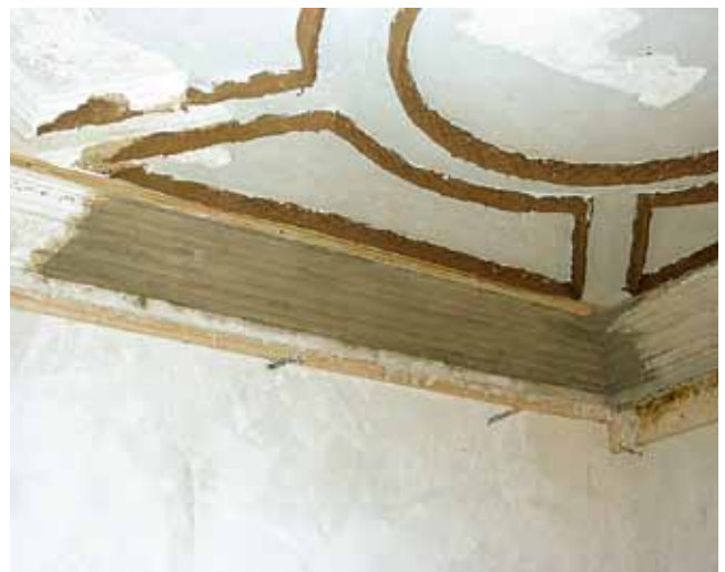
Abb. 24: Raum 105, Zwischenzustand – Gesimszug
