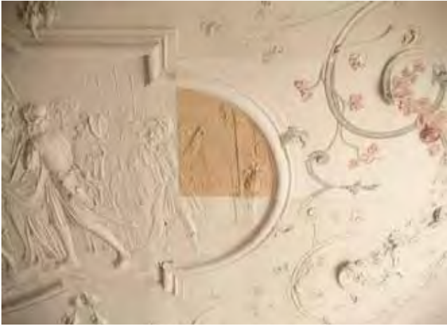
Abb. 3: Kartause Mauerbach, Kaisertrakt, Davidzimmer, Musterrestaurierung der polychromen Erstfassung (BDA Mauerbach)
