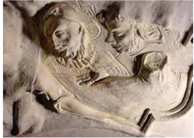
Abb. 4: Kartause Mauerbach, Refektorium Vorraum, Probefreilegung mit Resten der ockerfarbenen Erstfassung (BDA Mauerbach)
