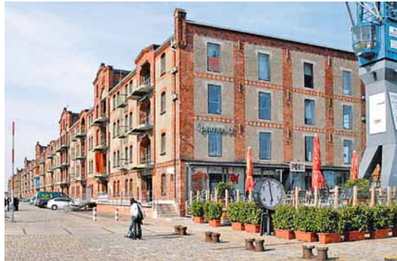
Abb. 9: Bremen, Überseestadt, Speicher 11
