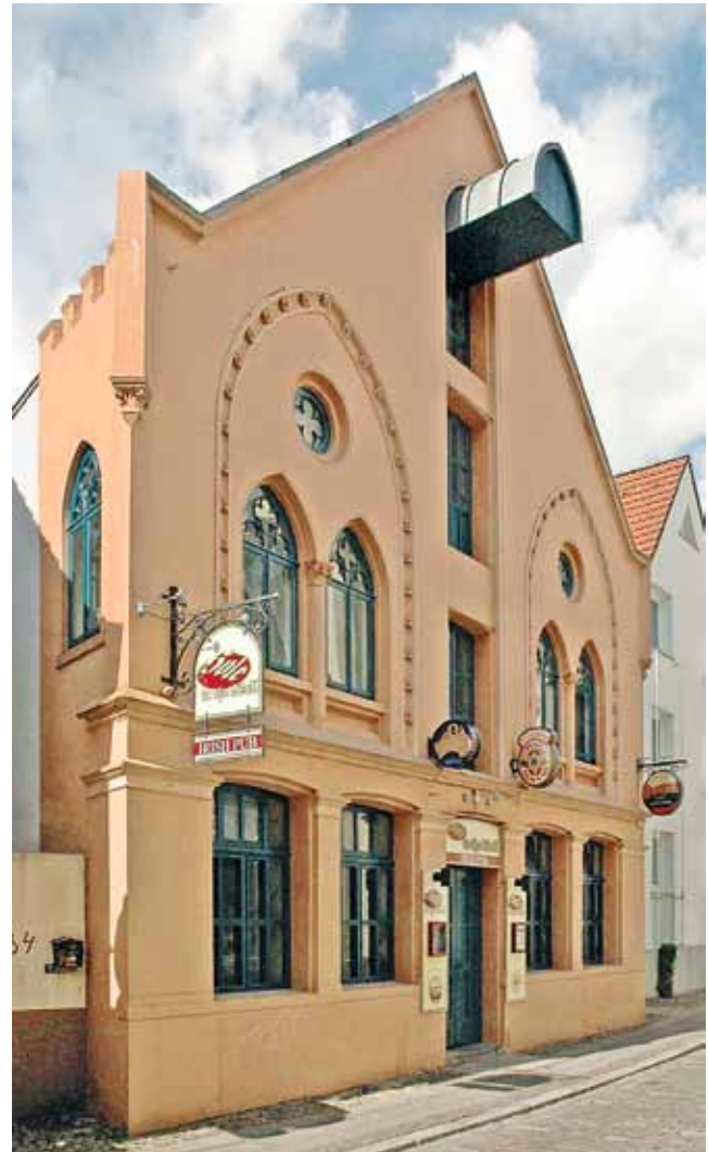
Abb. 6: Bremen, Vegesack, Speicher, Anfang 19. Jh., Fassade 1860
