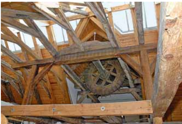
Abb. 8: Bremen, Vegesack, Lange-Speicher, 1805, Innenkonstruktion mit Winde
