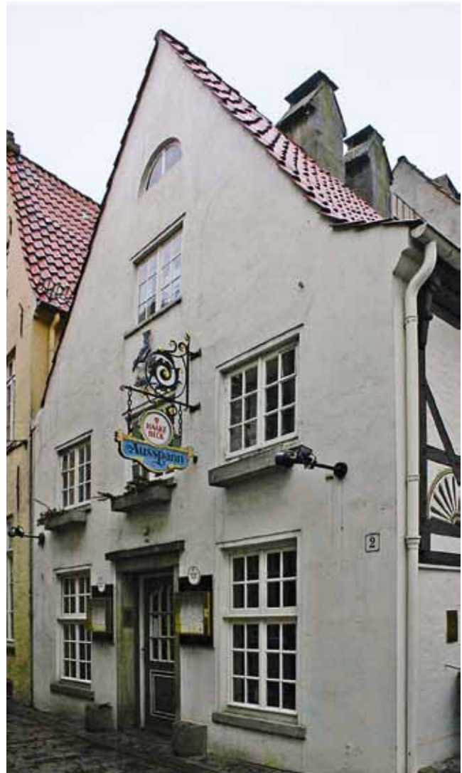
Abb. 1: Bremen, Schnoor: Speicher, Anfang 15. Jh.
