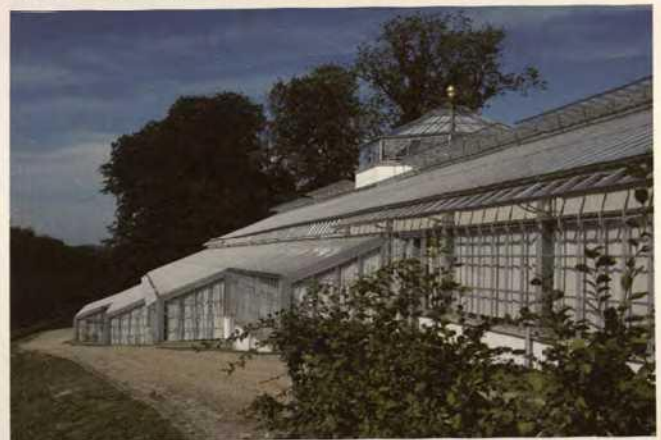
Abb. 11 Die angebauten terrassierten Gewächshäuser nach Süden
