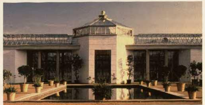
Abb. 9 Fredensborg, Orangerie, die Fassade nach Norden
