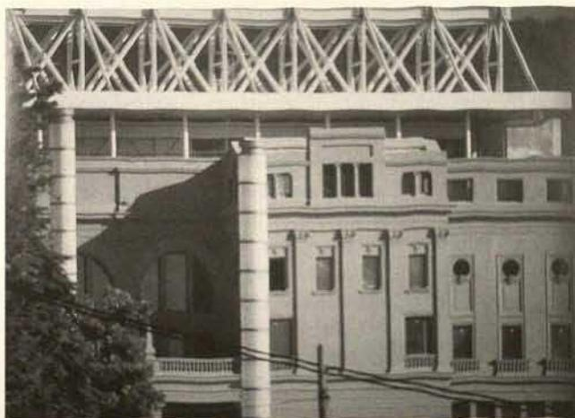
real. Die Konstruktion besteht aus Stahlbetonfertigteilen in Verbindung mit einem Stahltribürendachwerk. Die Massigkeit des Gebäudes wird durch die wellenförmige Anlage der Tribünen und des Tribürendaches aufgehoben.
