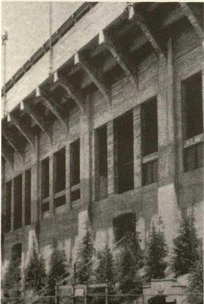
mantik wurde. Die Konstruktion aus Stahlbeton wird durch eine überwiegend aus Backstein bestehende Fassade verdeckt. Das Stadion ist mit viel Aufwand vor wenigen Jahren restauriert und in seinen Erstzustand zurückversetzt worden.
