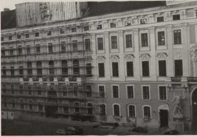
Abb. 3. Wien 1, Hofburg, Innerer Burghof, Reichskanzleitrakt, J. E. Fischer von Erlach um 1735, während Restaurierung 1989: beige Steinfarbe und Graufassung der überputzten originalen Rieselputzflächen
