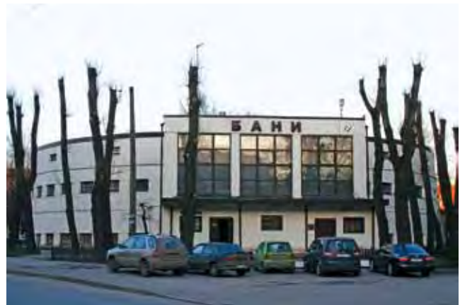
Badeanstalt des Vyborgskij Rayons – das „Runde Banja“ (1927–29, Atelier von Aleksandr Nikol'skij), 2007. «Кругая Баня» Выборгского Района (1927–29, Александр Никольский, мастерская). Фото 2007 г.
