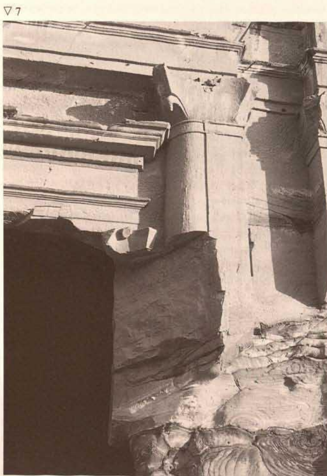
Abb. 6. Hegragrab, schrägverlaufender tektonischer Riß mit Schäden im Portalbereich
