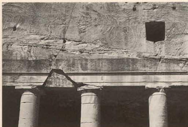
Abb. 5. Urnengrab, Peristyl, schrägverlaufender tektonischer Ri mit Absplitterung im Geblk
